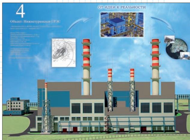
*Рис. 19. Нижнетуринская ГРЭС. Электрическая мощность – 460 МВт, тепловая – 274 Гкал/ч, топливо – природный газ. Дата окончания строительства – 2015 г.*
